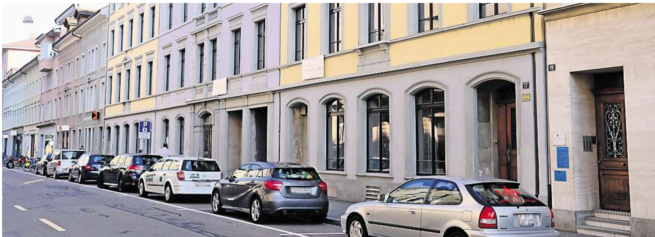
Die Holz-Metall-Fenster an der Wartstrasse 13 bis 17 mussten lange Zeit als Zankapfel zwischen der Stadt und dem Hausbesitzer Giovanni Cerfeda herhalten. Cerfeda ging schliesslich als Sieger aus dem Fensterstreit hervor. Nun hat die Stadt nach mehreren Jahren auf das Urteil reagiert und ihre Bauordnung angepasst.
