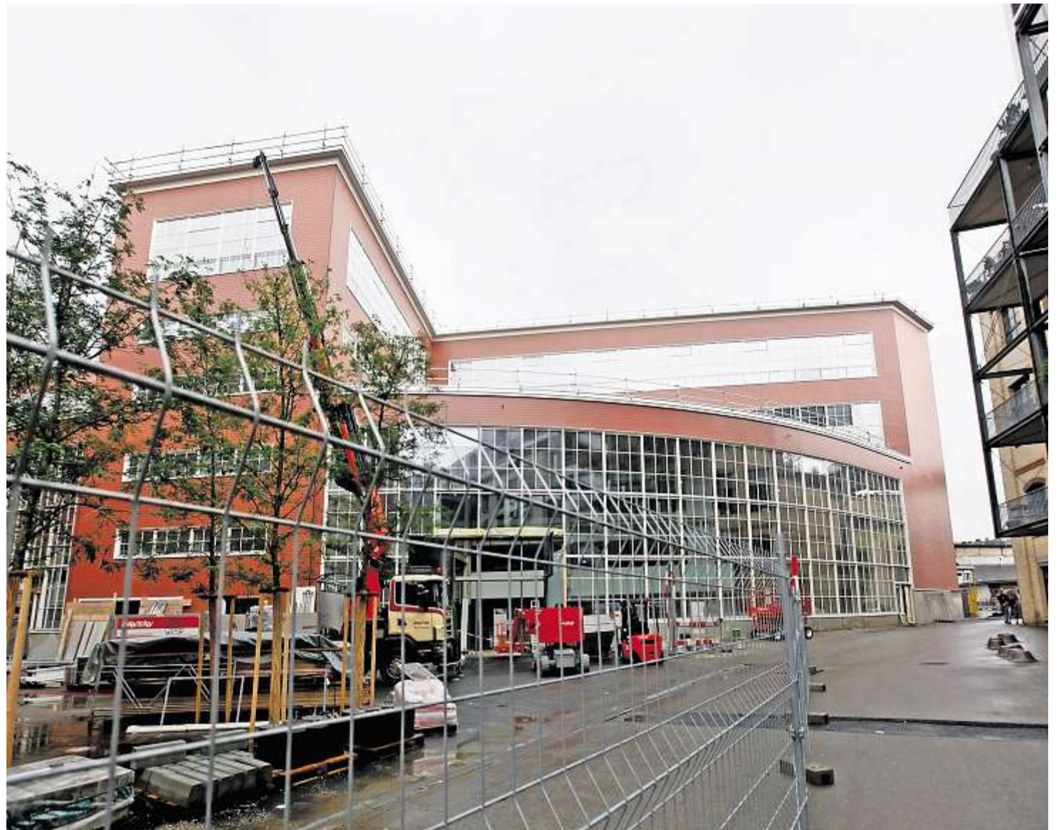
Noch wird in der Halle 87 auf dem Sulzer-Areal gearbeitet. Die neue ZHAW-Hauptbibliothek wird hier erst Anfang 2015 einziehen können. Nathalie Guinand
